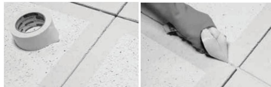
Para aplicação do rejunte, utilizar uma bisnaga, evitando sujar a superfície das peças.
